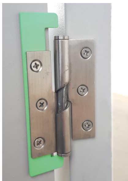
Figura 34: Fixação da trava antifurto da dobradiça
