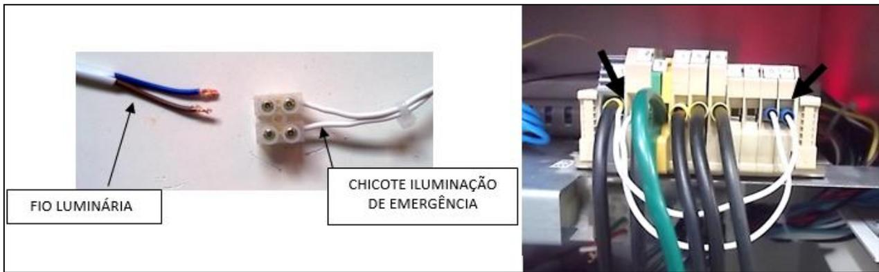
Figura 13: Ligação da luminária de emergência
